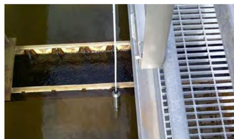
Capteur du transmetteur de niveau de boues OPTISYS SLM 2100
