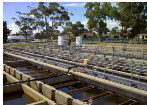
Transmetteur de niveau de boues monté sur bassin de sédimentation
