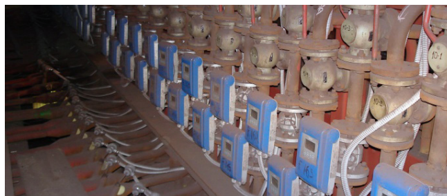
OPTIFLUX 2100 C monté dans des circuits de refroidissement
