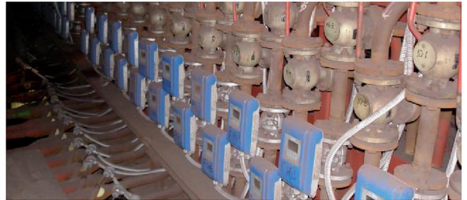
OPTIFLUX 2100 C in Kühlkreisläufen
