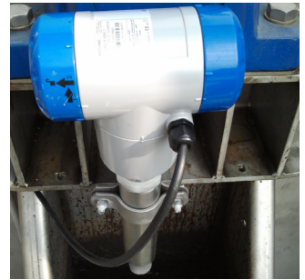
Einbau des OPTIWAVE 5200 C mit horizontaler Gehäuseposition
