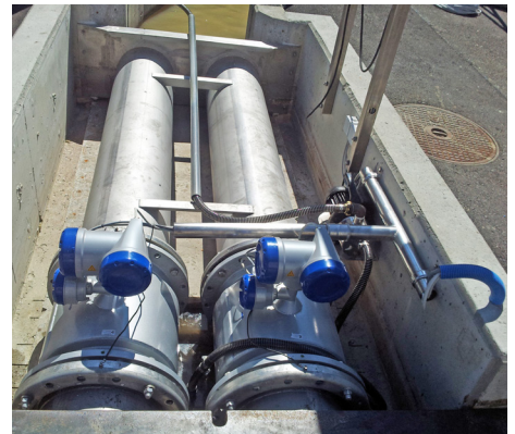
Einbau des TIDALFLUX 2300 im Abwasserkanal
