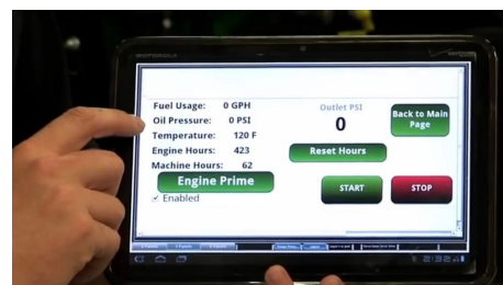
Anzeige des Pumpenleitsystems
