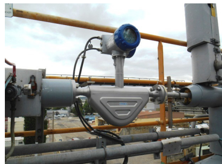
Установка OPTIMASS 6400
