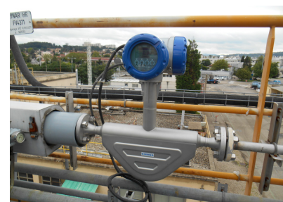
Messung von Gasmisch mit dem OPTIMASS 6400 C
