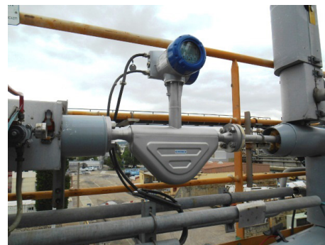
Installation des OPTIMASS 6400
