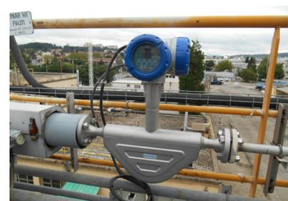
Medida de la mezcla de gases con el OPTIMASS 6400 C
