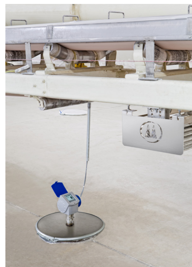
Монтаж OPTIWAVE 6300 C
