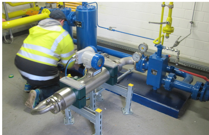
Компактный монтаж OPTIMASS 7300 С на измерительной установке
