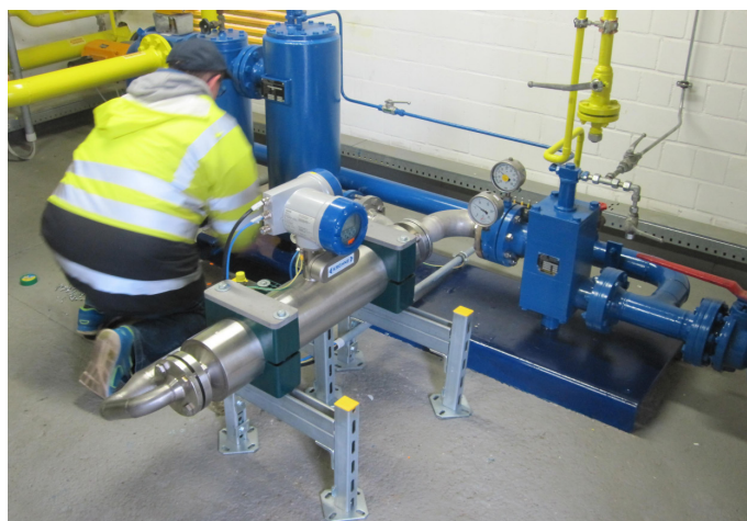
Montage compact de l'OPTIMASS 7300 C dans le système de mesure
