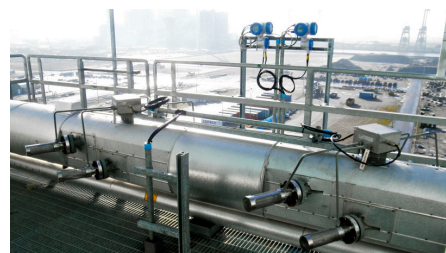
Mesure de vapeur avec l'OPTISONIC 8300
