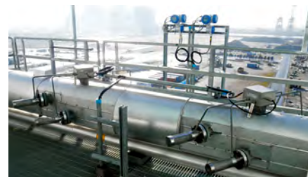
Dampfmesung mit dem OPTISONIC 8300
