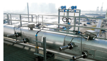
Измерение расхода пара с помощью OPTISONIC 8300
