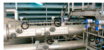
Измерение расхода конденсата с помощью OPTISONIC 4400
