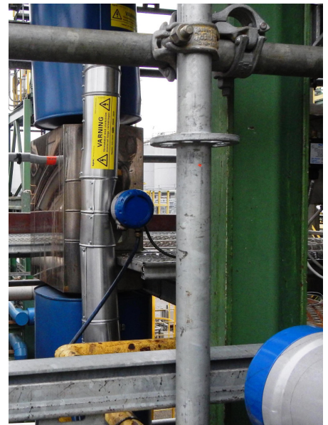
OPTIMASS 6400 F mit Isoliermantel und Anschluss an Begleitheizung
