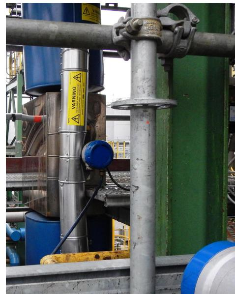
OPTIMASS 6400 F с изоляционным кожухом и подсоединенный к системе обогрева
