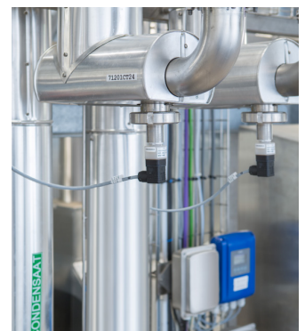
Leitfähigkeitsmessung mit dem OPTISENS COND 1200 und dem MAC100 Messumformer
