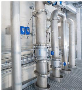
Измерение расхода сточных вод от молочного производства с OPTIFLUX 2100 F
