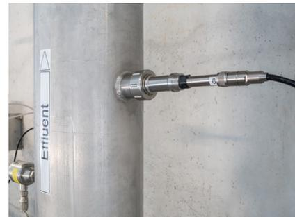
pH измерение расхода сбрасываемой воды с SMARTPAT pH 8150
