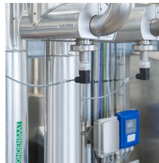
Измерение проводимости с OPTISENS COND 1200 и преобразователем сигналов MAC 100
