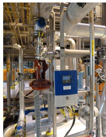
Débitmètres électromagnétiques sur circuits d'eau
