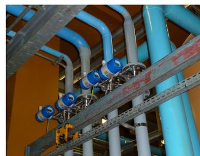
Débitmètres Vortex sur air comprimé
