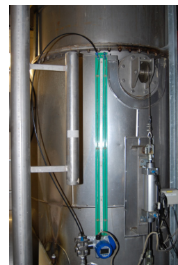
Differenzdruckmessung an der Würzepfanne
