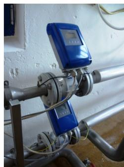
Wassermessung mit dem WATERFLUX 3100 C
