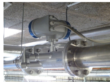
Alimentation du groupe électrogène avec l'OPTISONIC 7300
