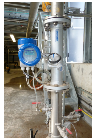
Débitmètre ultrasons OPTISONIC 7300 C pour biogaz
