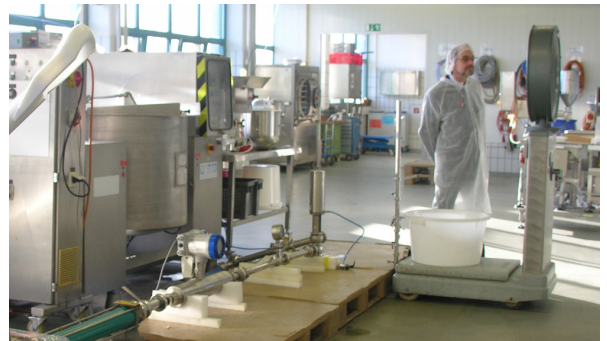
Testinstallation mit dem OPTIMASS 7400 C
