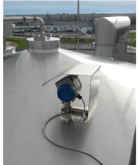
OPTIWAVE 7300 C mit hygienischem Tri-Clamp-Anschluss
