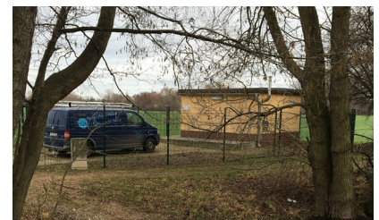
Pumpwerk des ZVO
