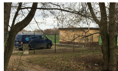
Насосная станция ZVO
