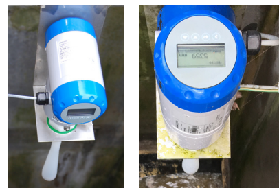
Быстрая модернизация преобразователя благодаря системе быстроразъемного соединения
