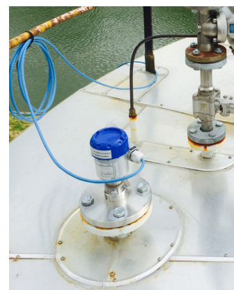
Измерение избыточного давления в слое азота
