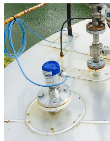
Transmetteurs de pression OPTIBAR mesurant le ciel d'azote
