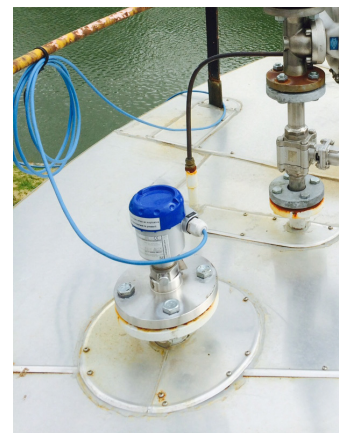
Medida de la presión manométrica de una capa de nitrógeno
