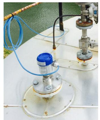
Überdruckmessung des Stickstoffschleiers
