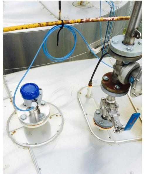
Druckmessumformer OPTIBAR PC 5060 C oben am Behälter
