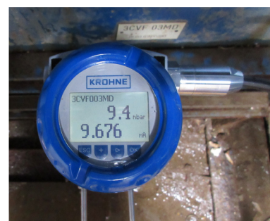
OPTIBAR DP 7060 C IP 68 Messung des Rohwasserzulaufs
