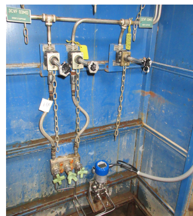
OPTIBAR DP 7060 C Differenzdruckmessumformer
