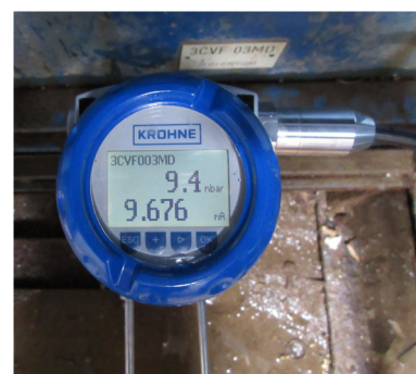
OPTIBAR DP 7060 C IP 68 измерение потребления неочищенной воды
