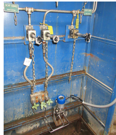
Преобразователь дифференциального давления OPTIBAR DP 7060 C
