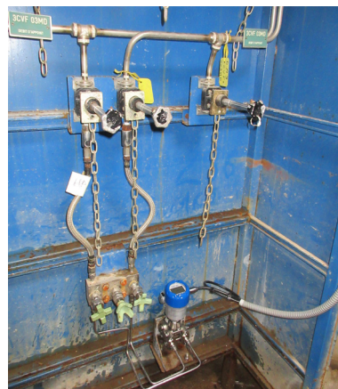
Transmetteur de pression différentielle OPTIBAR DP 7060 C
