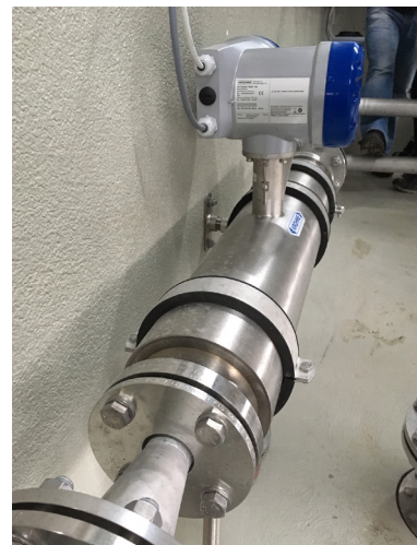
Durchfluss- und TS-Messung von Überschussschlamm mit dem OPTIMASS 7400 C
