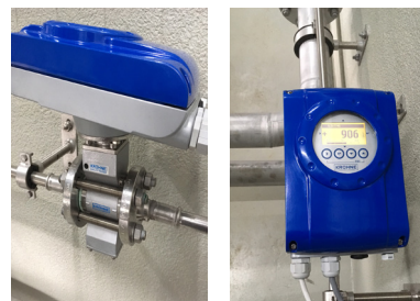
Flockungsmittel-Messung mit dem OPTIFLUX 1050 C
