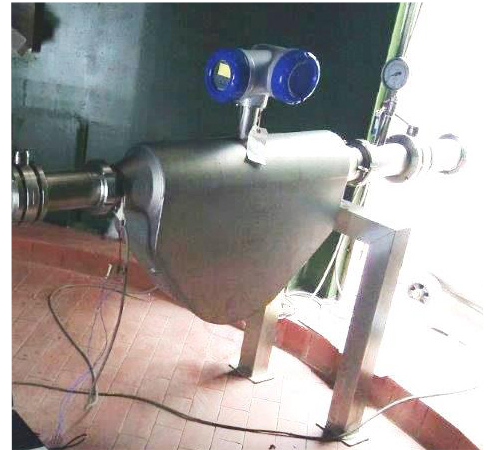
Installation des OPTIMASS 6400 (DN100) mit SMS-Anschluss zur hygienischen Durchflussmessung von Frischbier
