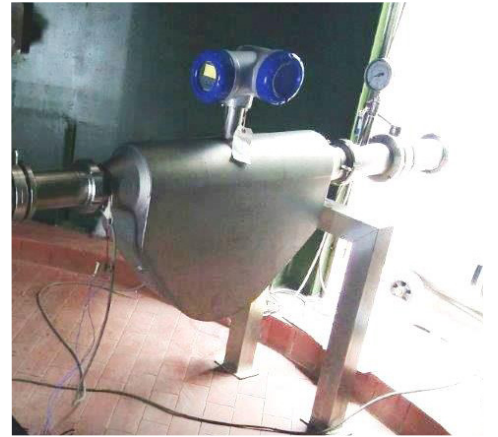
Instalación del OPTIMASS 6400 (DN100 / 4") con conexión SMS higiénica
