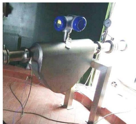
Installation de l'OPTIMASS 6400 (DN100) avec connexions SMS pour la mesure de débit hygiénique de la bière filtrée
