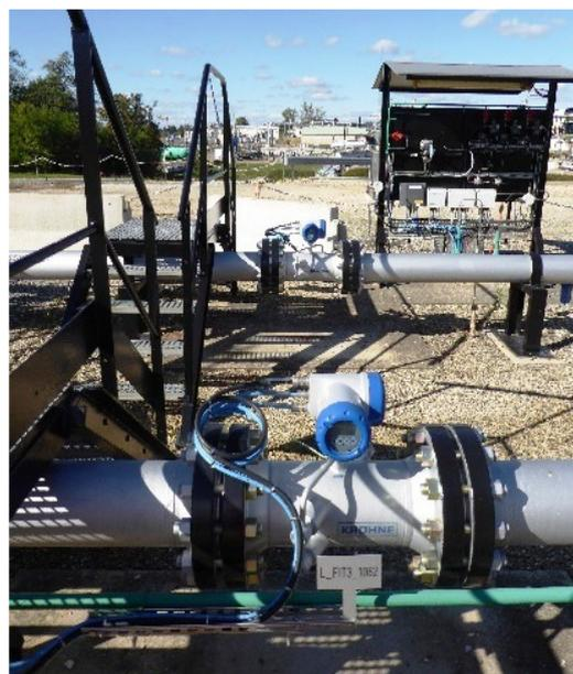
Ultraschall-Durchflussmessgerät OPTISONIC 7300 bei der Erdgasmessung
