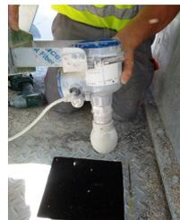
OPTIWAVE 6400, установленный наверху элеватора для хранения
