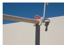
OPTIWAVE 6400 monté au-dessus de la trémie d'alimentation
