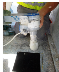
OPTIWAVE 6400 installé au sommet du silo
