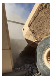
Camion déchargeant la pierre
