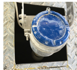
OPTIWAVE 6400 installé au sommet du silo
