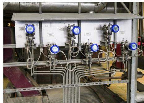
Преобразователь дифференциального давления OPTIBAR DP 7060 C для зонального регулирования воздуха на дне резервуара
