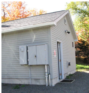
Pumpstation, in der das Messsystem installiert ist
