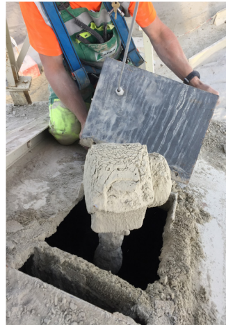
Ausbau des bisherigen OPTIWAVE 6300 Füllstandmessgeräts
