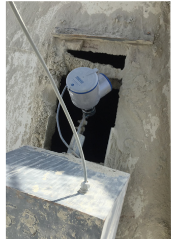
Umrüstung mit frontbündigem OPTIWAVE 6500 Radar-Füllstandmessgerät
