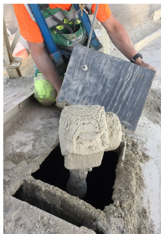
Снятие с позиции прежнего радарного преобразователя OPTIWAVE 6300
