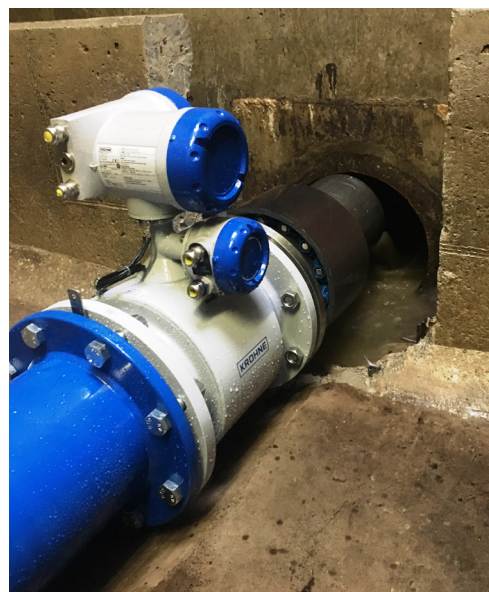
TIDALFLUX 2300 – расходомер для безнапорных трубопроводов
