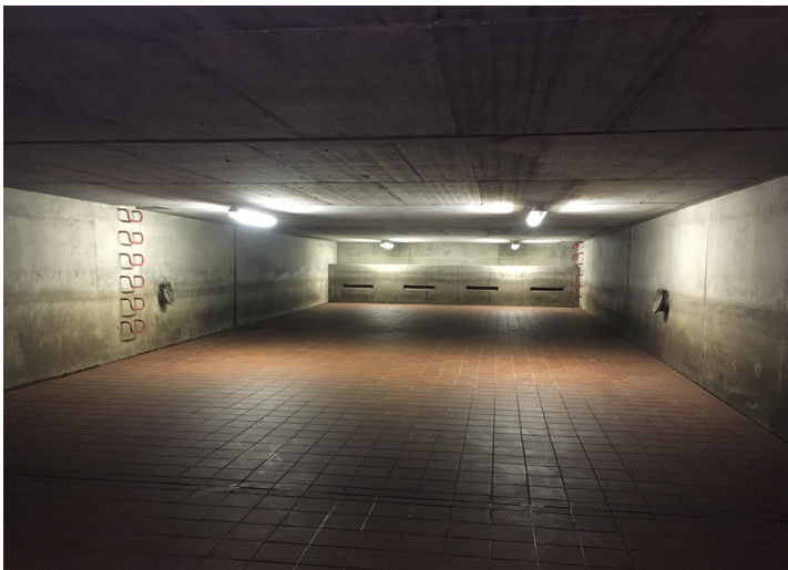
Unterirdisches Regenüberlaufbecken der Gemeinde Schlangen
