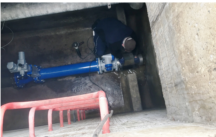
Installation der Messtechnik
