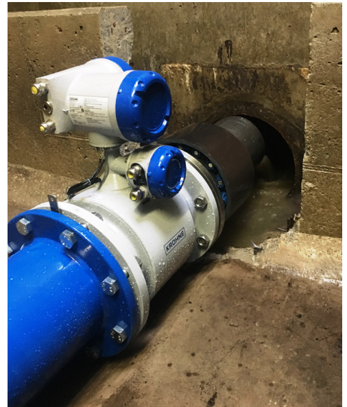
TIDALFLUX 2300 – Durchflussmessgerät für Freispiegelleitungen
