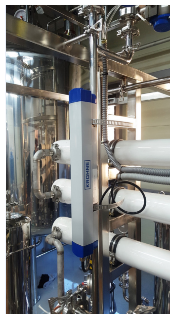
Clamp-on-Durchflussmessgerät beim Messen von Wasser für Injektionszwecke (WFI)
