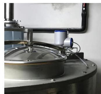
OPTIWAVE 7500 monté sur des réservoirs de chocolat
