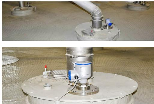
Installation neben dem Einfüllstutzen
